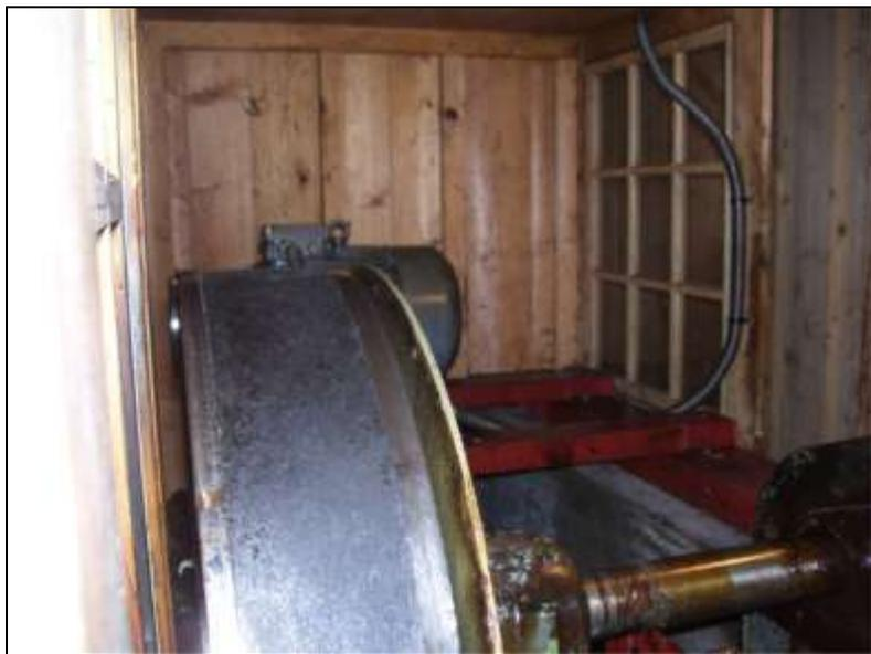
**Bild 58: Kleinstkraftwerk Gössl: Antrieb des Asynchrongenerators. Wirkleistung max. 4 KW, Spannung 3x 400/231 Volt. (Foto: Martin Gschwandtner 10. März 2013).**
