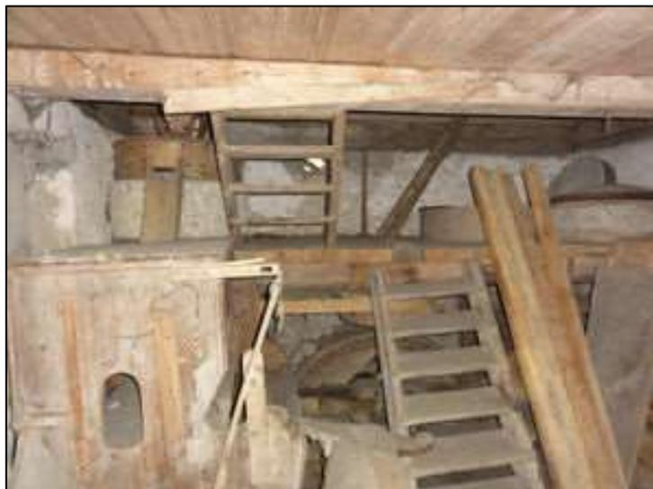
**Bild 53: Blick durch ein Fenster ins Innere der Mühle, links oben neben der Stiege ein Mahlgang, links unten der zugehörige Mehlkasten, rechts oben der Lagerstein und hinten an der Wand der Läuferstein des zweiten Mahlganges. (Foto: Franz Fuchs, 23. Juli 2013).**
