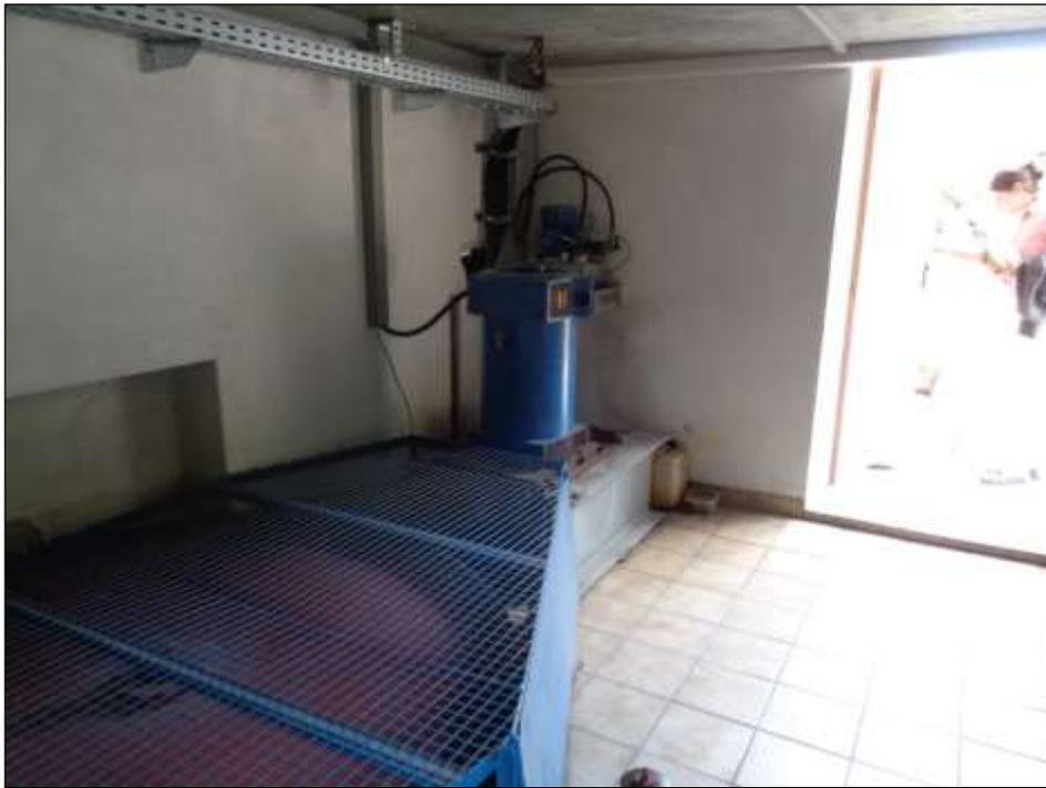
**Bild 60: Kleinkraftwerk Enzinger, Antrieb des Generators, Fabr. Hitzinger, 25 KVA
